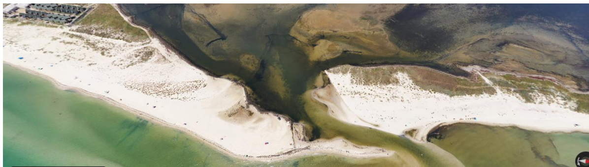
Рис.4.2. Прорва в притульній частині Джарилгачу, стан на вересень 2019 р. (розроблено автором на базі ресурсу Google Earth)
