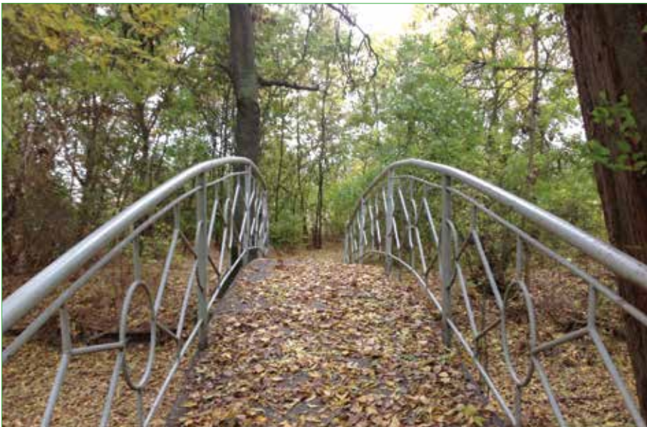
Хорли. Арочний місток через канал
