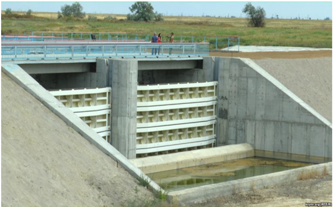
Рис. 3.2. Бетонна дамба на Північно-Кримському каналі
