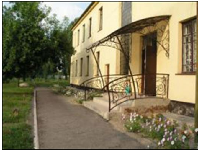
Рис. 2.5 Фото спального корпусу санаторію «Гопри» (наш час)
