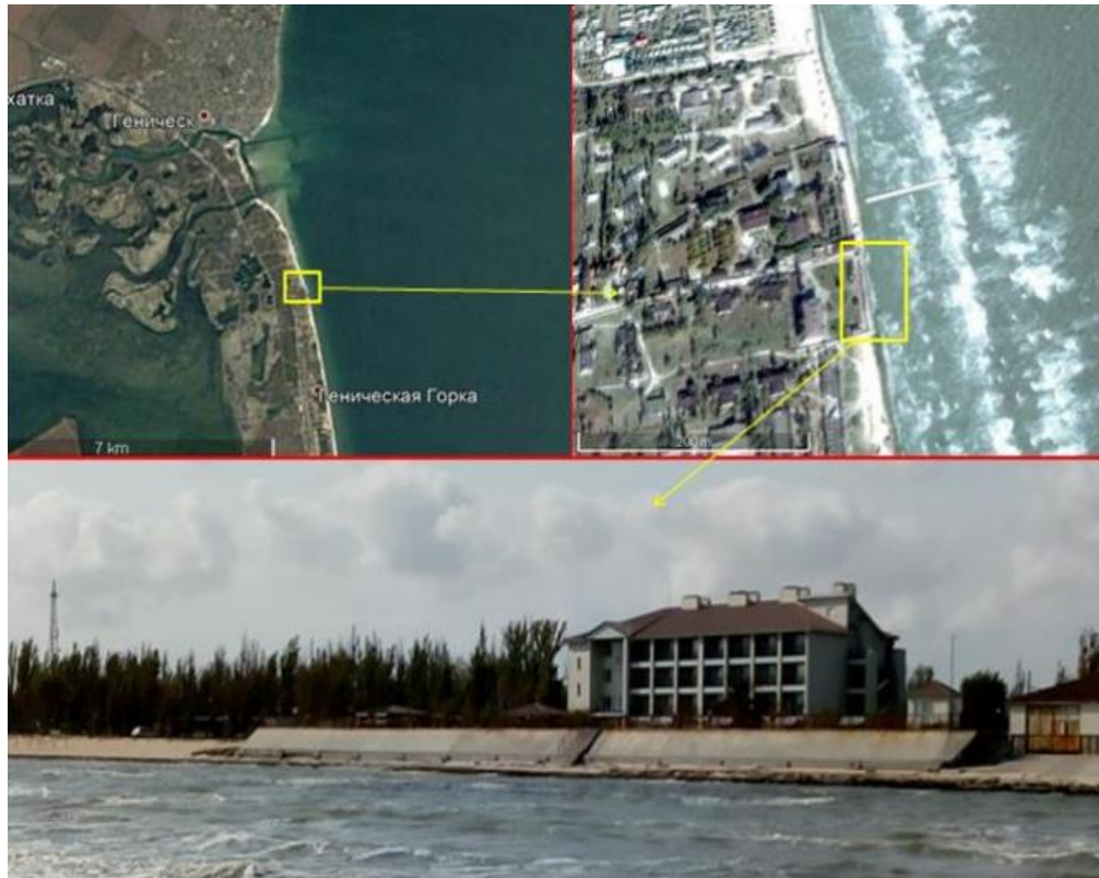
Рисунок 3.5 Хвилевідбійна стінка в межах населеного пункту Генічеська гірка на території пансіонату «Ялиночка» (фото автора) [34].
