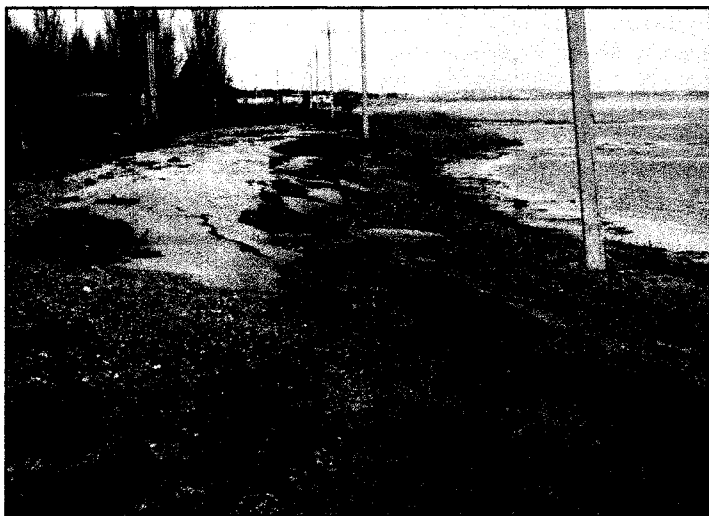
Мал.1. Абразійно небезпечна ділянка Джарилгацької затоки в межах східної частини смт Лазурне, зруйнована внаслідок штормового нагону дорога.
