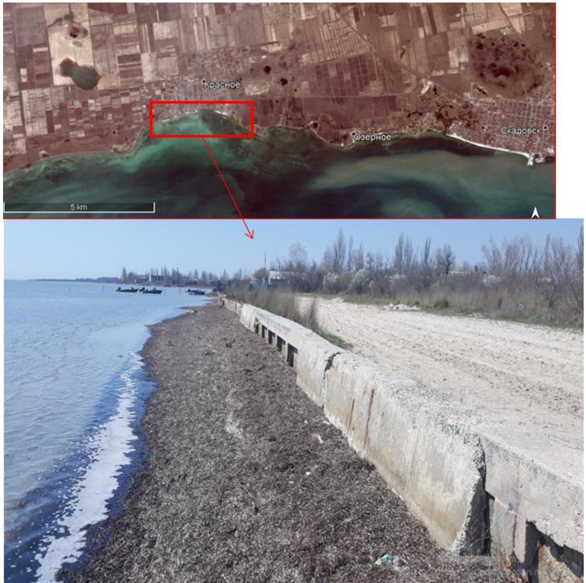
Рис.3.7. Хвилевідбійна стінка в межах селища Красне (фото автора) [34].
