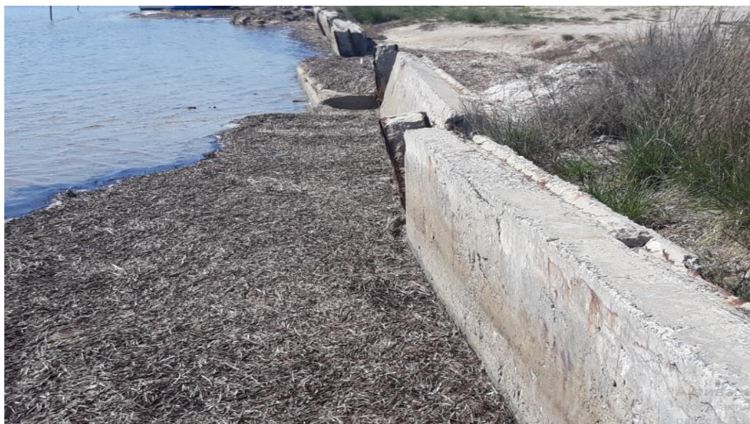
Рис.3.8. Зображення деформації залізобетонних блоків та їх нахилання в бік акваторії та суші в межах селища Красне (фото автора).
