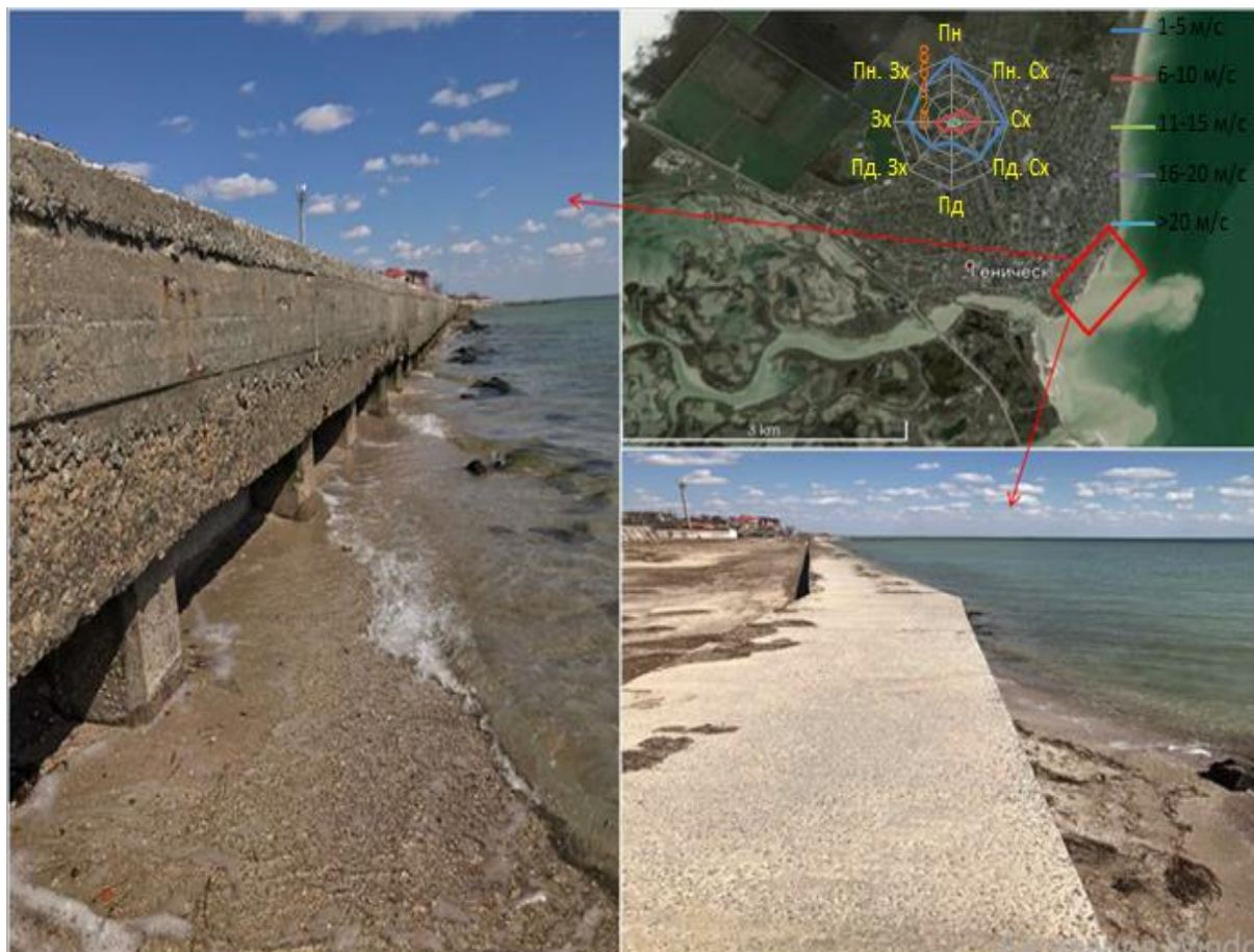
Рис.3.9. Хвилевідбійна стінка в межах міста Генічеськ (фото автора) [34].
