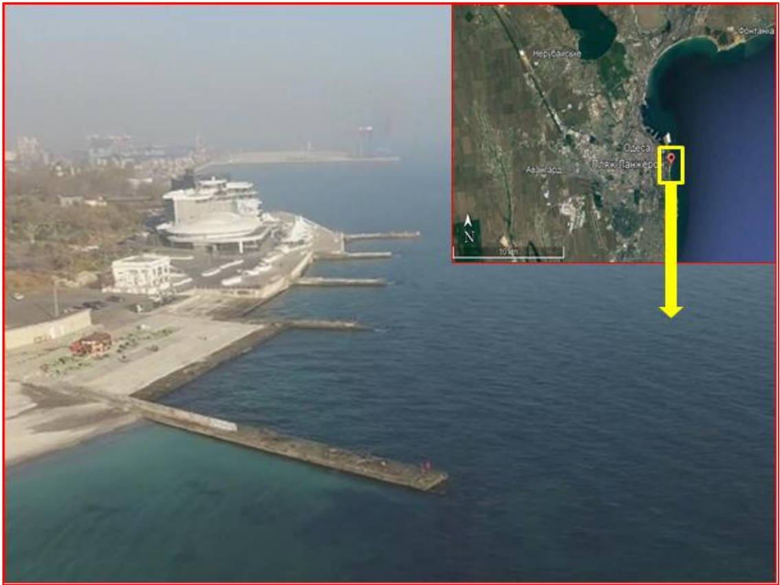
Рис.1.10 Система хвилерізів м. Одеса міський пляж Ланжерон [39].
