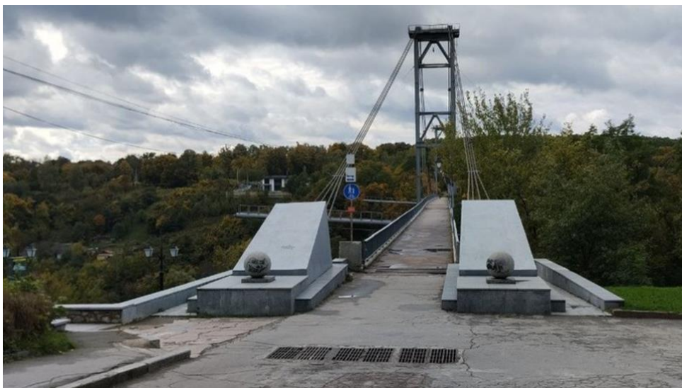
Рис.1.5 Підвісний пішохідний Парковий міст
