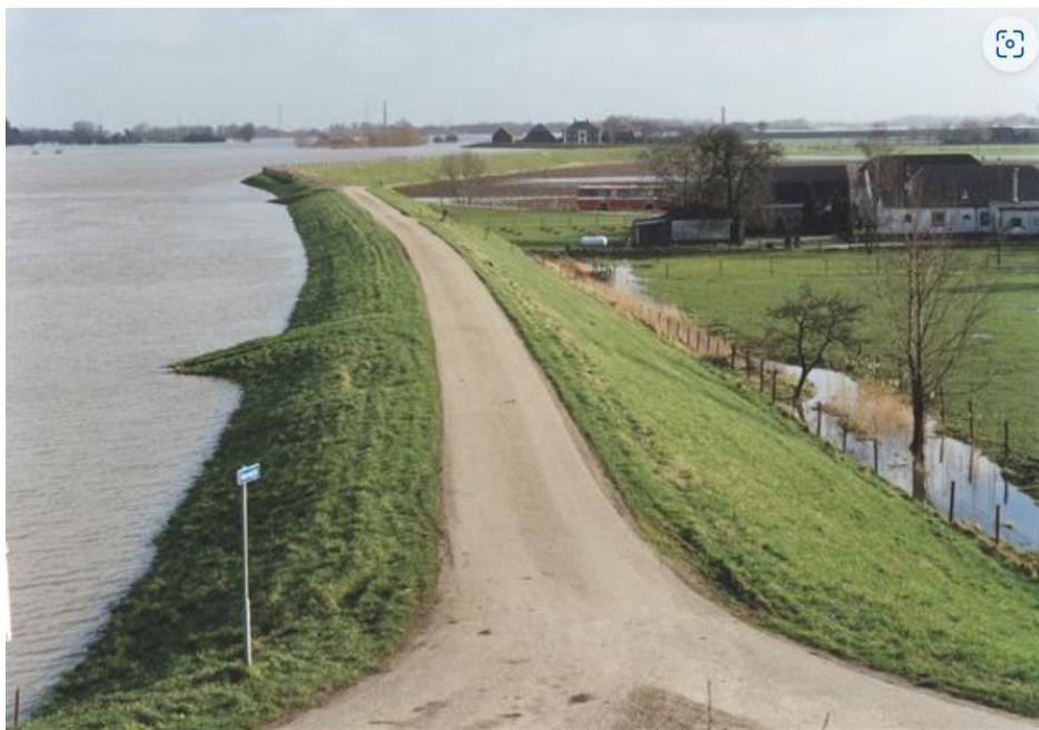
Рис.1 Вигляд земляної дами
