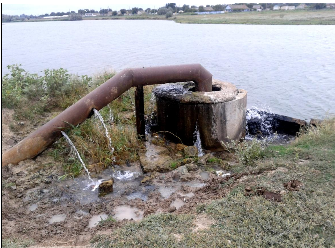
Рис. 2.5 – Вихід стоку дренажної споруди до русла річки
