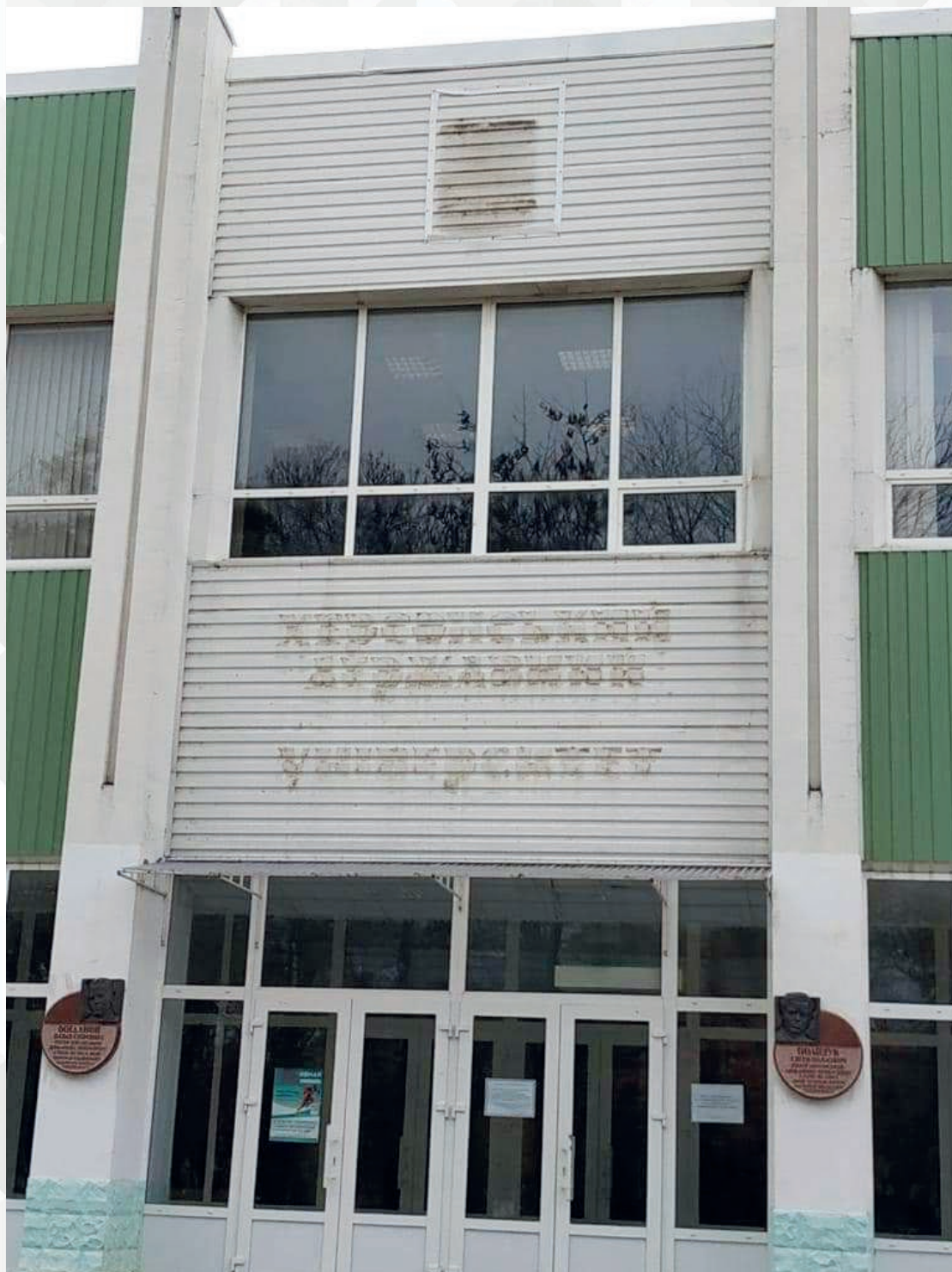
Фасад головного корпусу ХДУ
