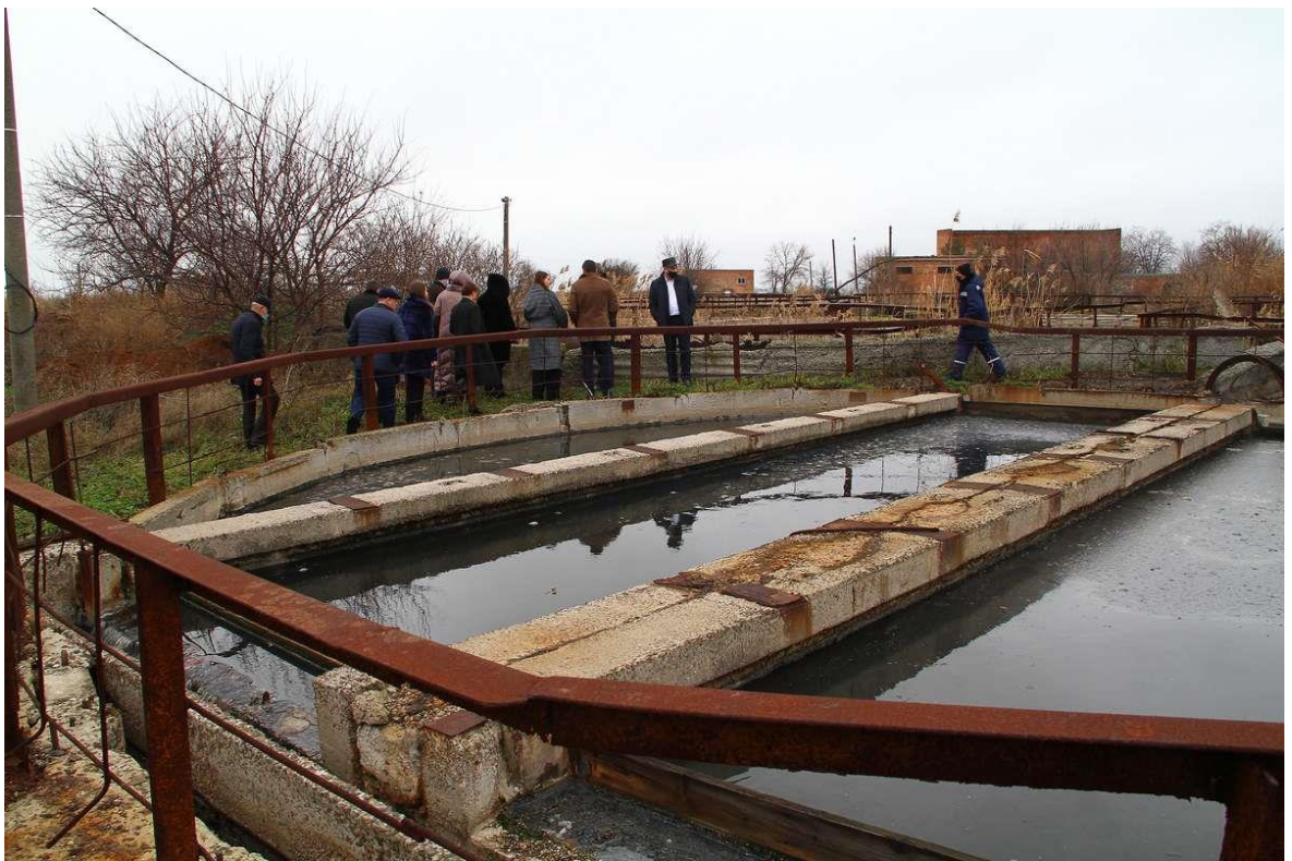
Рисунок 2.1 – Каналізаційні очисні споруди в м. Пологи (Запорізька область)
