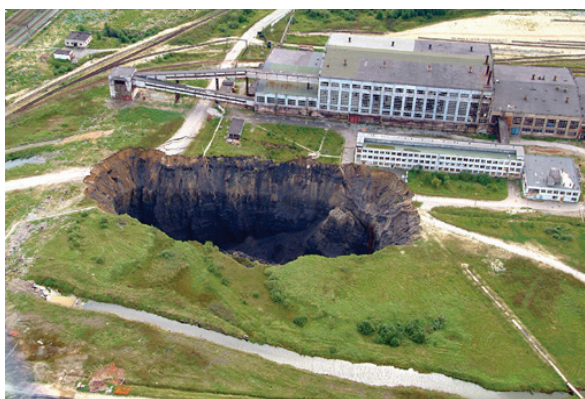
Провал підстелюючої поверхні в зоні розташування затоплених рудників підприємства «Уралкалій».
