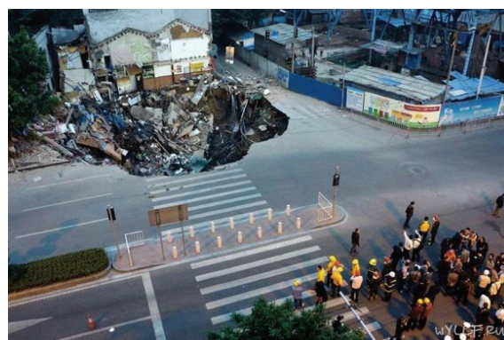
У китайському місті Гуанчжоу під землю провалилися чотири будинки. Причина - будівництво під будинками метрополітену.
