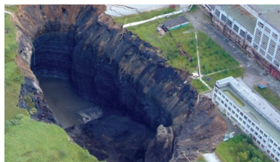
Провал підстелюючої поверхні в зоні розташування затоплених рудників підприємства «Уралкалій».
